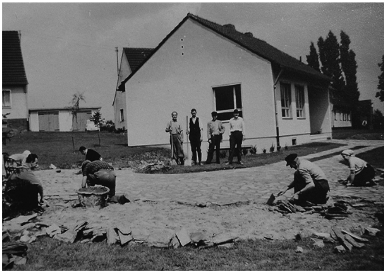
Die Pflasterarbeiten wurden in Eigenleistung durch Gemeindeglieder ausgeführt
