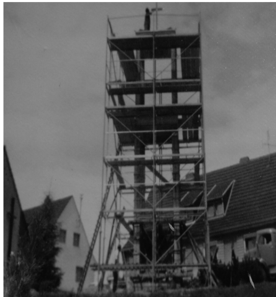
Auch wenn er auf diesem Foto nicht zu erkennen ist: Reinhard Paul montiert das von ihm entworfene und gearbeitete Kreuz Das Material dazu wurde vom Martinswerk / Bergheim gespendet
