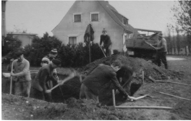
Ausschachtarbeiten durch fleißige Helfer aus der Gemeinde
